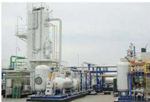
Рисунок 1 – Завод по сжижению природного газа (ООО «Сибирь-Энерго»)
