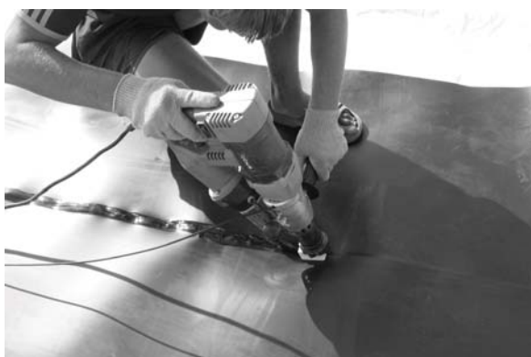
Рисунок 1 – Экструзионная сварка полиэтиленового листа марки ПЭНД
