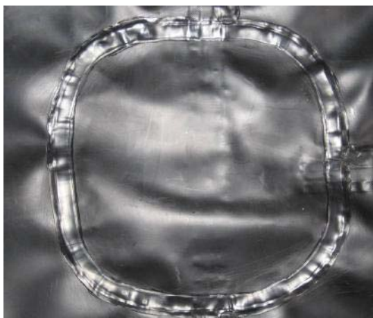
Рисунок 2 – Усиление стыка геомембраны накладкой, приваренной экструзионной сваркой
